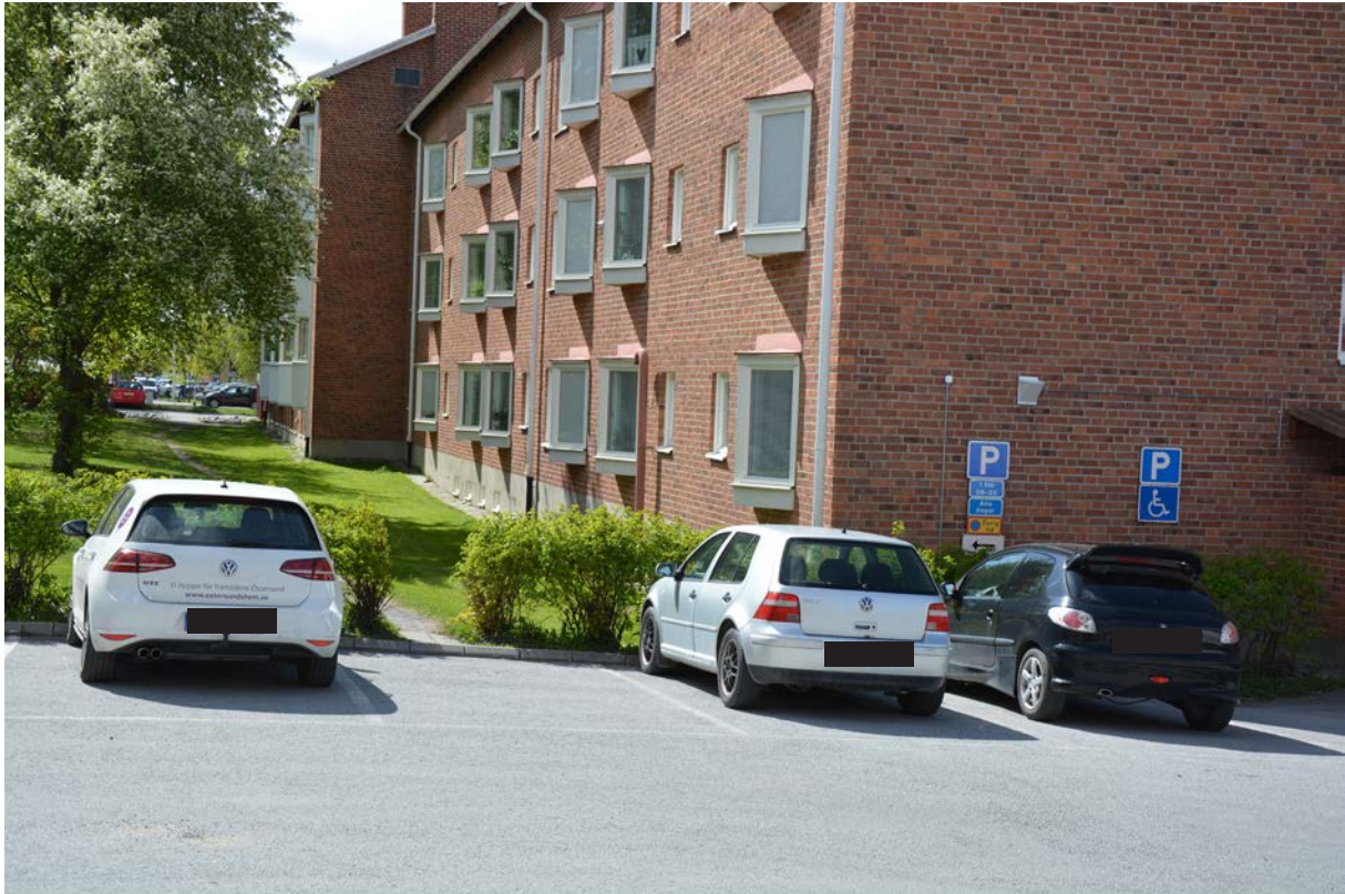
Figur 9. Byggnad inom området Hjorten som riskerar att få stående vatten på upp emot 1 meter mot fasaden. I bilden går det att se att marken sluttar ner mot byggnadens hörn, vilket riskerar att leda till att vattnet fortsätter att flöda hitåt även efter skyfallet. Det går även att se att byggnaden har källarfönster, vilket kommer leda till vattenintrång (Bild tagen av Thomas Stoll).
