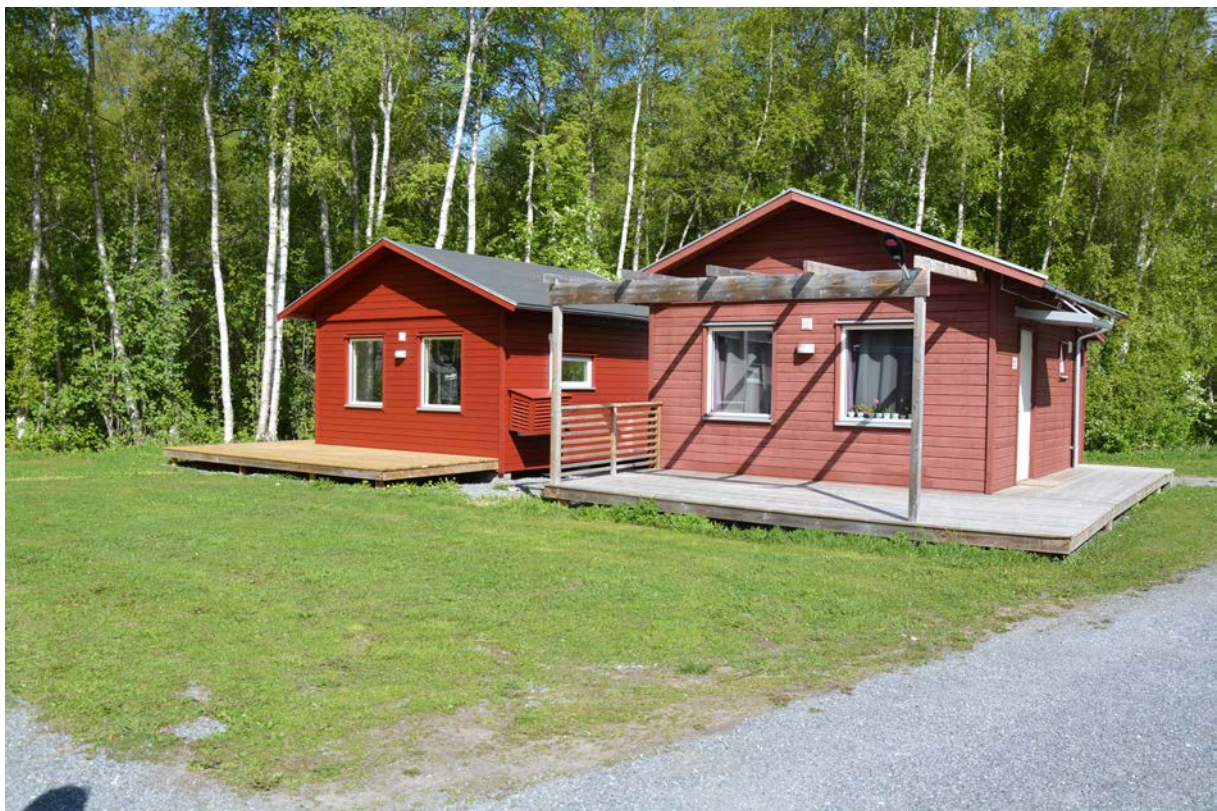
Figur 5b. Exempel på byggnader som enligt karteringen riskerar att få 0.1-0.3 m högt vatten mot fasad. Då husen står på printar kan detta leda till allvarliga konsekvenser där husen rör på sig och i värsta fall trillar av (Bild tagen av Thomas Stoll).
