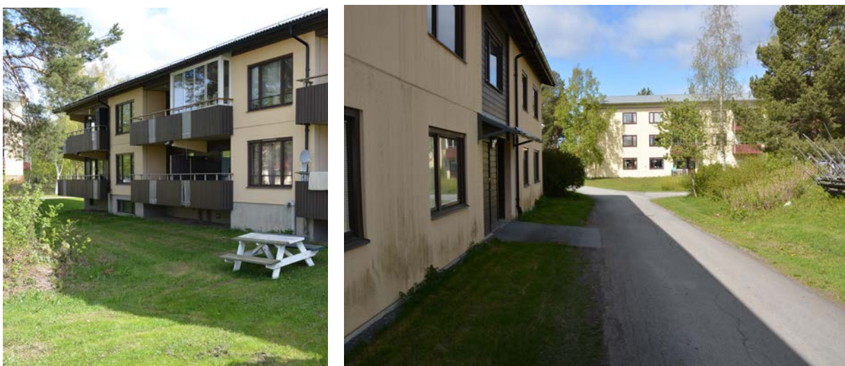
Figur 4. Exempel på byggnader i området Skifteslaget. I bilden till vänster kan man se att vatten som uppgår till 0.5 meter kommer tränga in i byggnaden via källarfönster. I bilden till höger ser man entré till byggnaden som är i markplan, vilket leder till inträngning av vatten om det blir stående mot fasaden (bilder tagna av Thomas Stoll).
