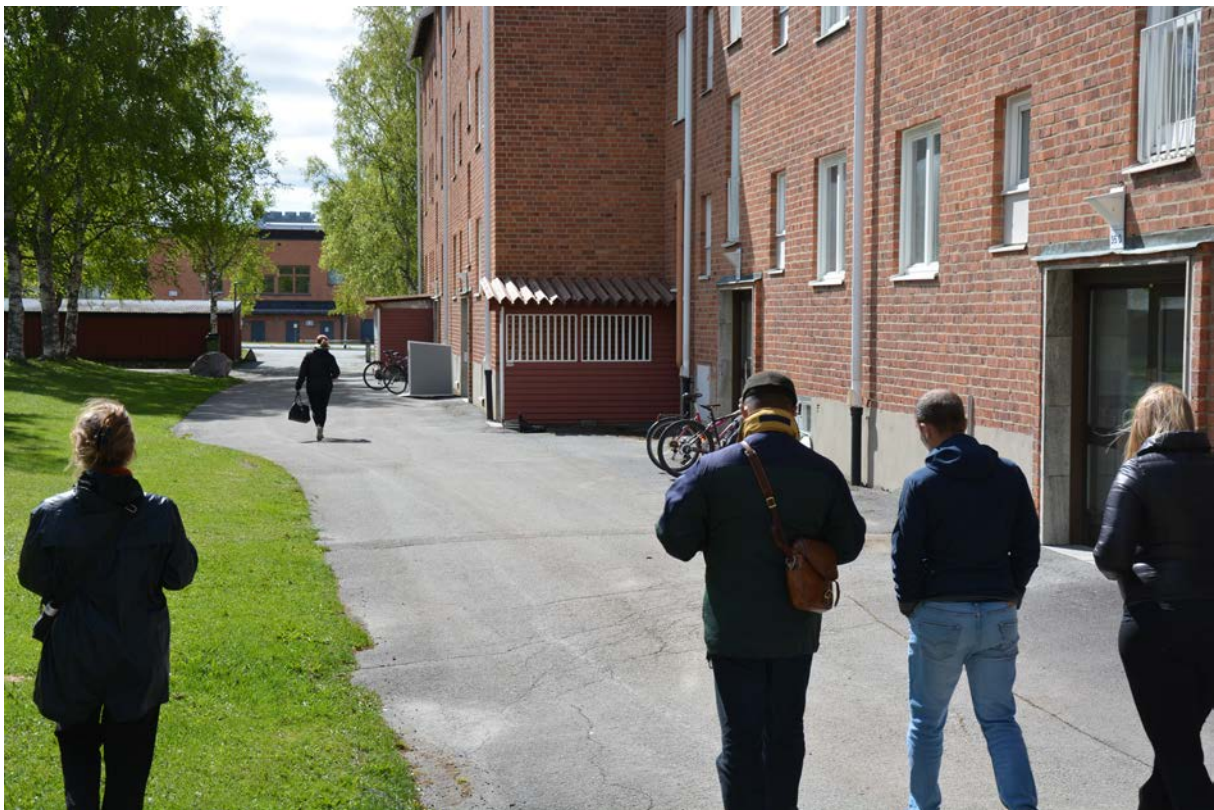
Figur 10. Byggnad inom området Hjorten där vatten beräknas stå mot fasad. Som kan ses i bilden är entréerna i markhöjd vilket riskerar att leda till vatteninträngning (Bild tagen av Thomas Stoll).
